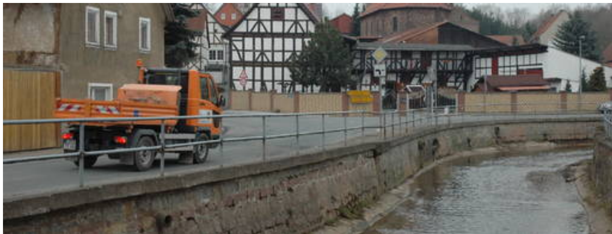
Für die Erneuerung der Stützwand in Mengelrode sind 230.000 Euro veranschlagt. Foto: Jürgen Backhaus
