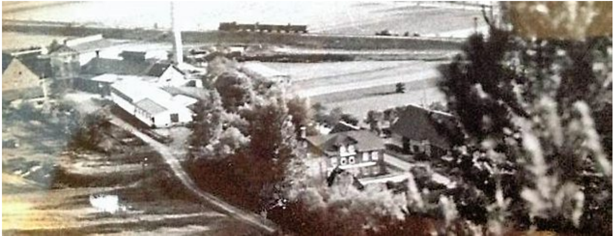
Ein Blick auf die Heiligenstädter Papierfabrik, direkt an der Bahnstrecke gelegen. Foto: Eisenbahnverein
