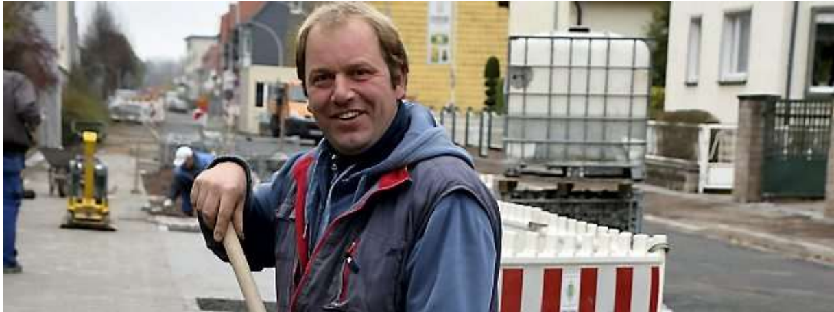
Die Baustelle in der Leinefelder Lutherstraße wird auch noch in diesem Jahr fertig. Daniel Wels und seine Kollegen sind bereits mit den letzten Pflasterarbeiten des Gehweges beschäftigt. Foto: Silvana Tismer
