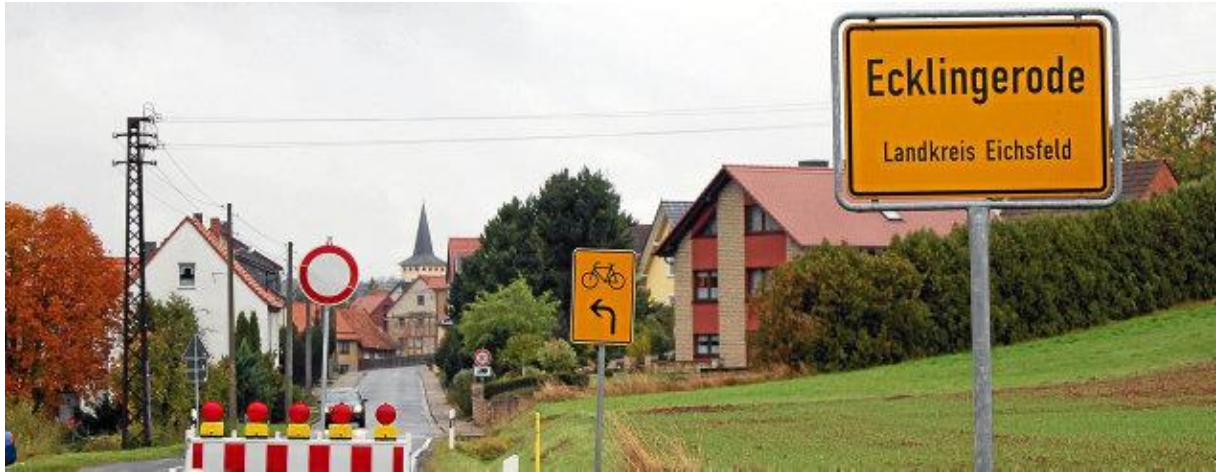
Die Ortsdurchfahrt Ecklingerode ist wegen Straßenbauarbeiten bis 30. November gesperrt. Das Straßenbauamt investiert hier 130 000 Euro. Foto: Sigrd Aschoff
