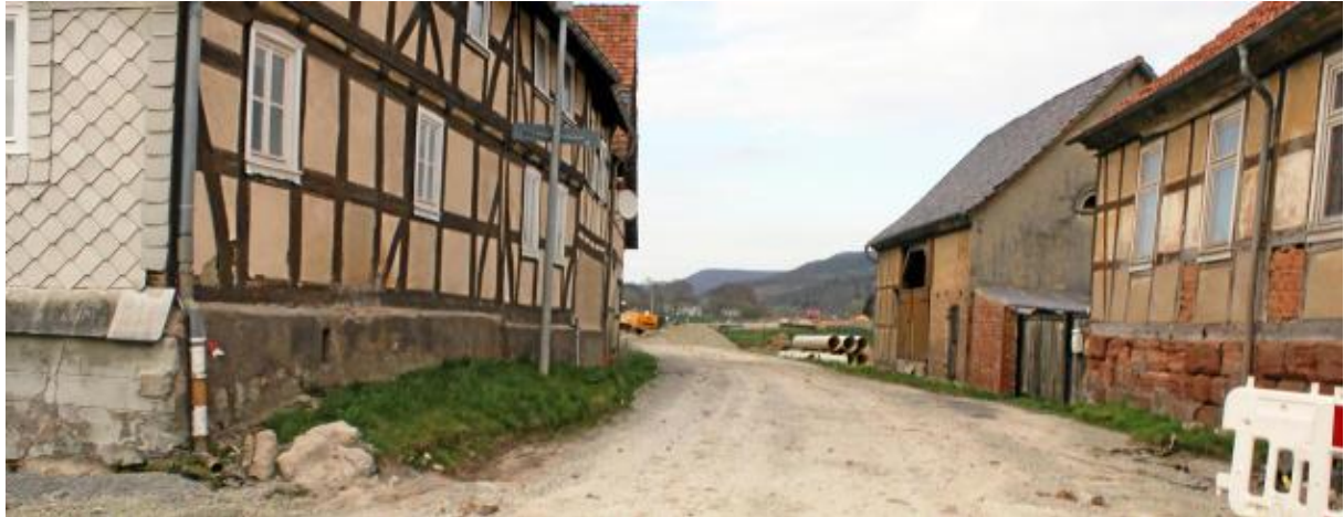
Mit dem Abtragen des denkmalgeschützten Hauses, im Bild links, und der Scheune, die sich dahinter anschließt, soll in Großtöpfer Platz für den grundhaften Ausbau der Kreuzung an der Landesstraße geschaffen werden. Foto: Straßenbauamt Nordthüringen
