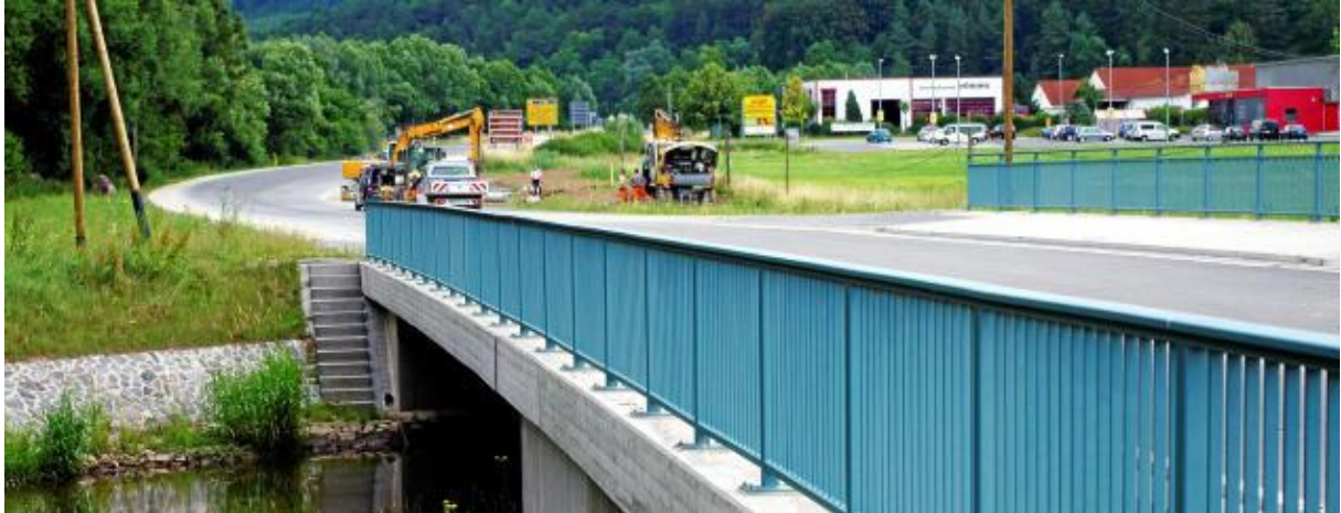
Blick entlang der bereits vor einigen Jahren neu gebauten Brücke in Richtung der Kreuzung bei Geismar. Foto: Jürgen Backhaus
