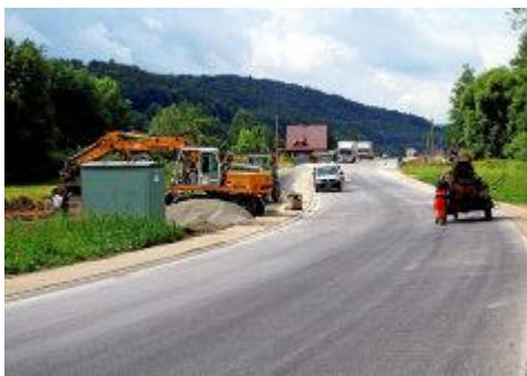
Die Baustellen der Landesstraßen-Kreuzung bei Geismar Foto: Jürgen Backhaus
