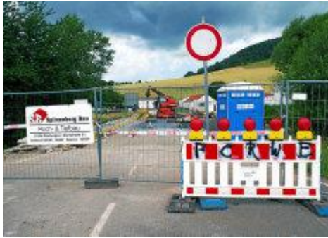
Noch ist die Straße gesperrt. Foto: Jürgen Backhaus
