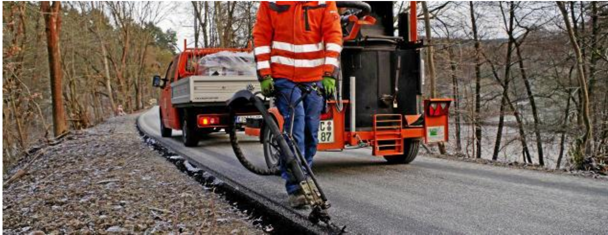
Mike Trümper von der Firma TWE Uder verflankte gestern mit flüssigem Bitumen die Kante der Deckschicht des Radweges auf dem alten Bahndamm. Foto: Jürgen Backhaus
