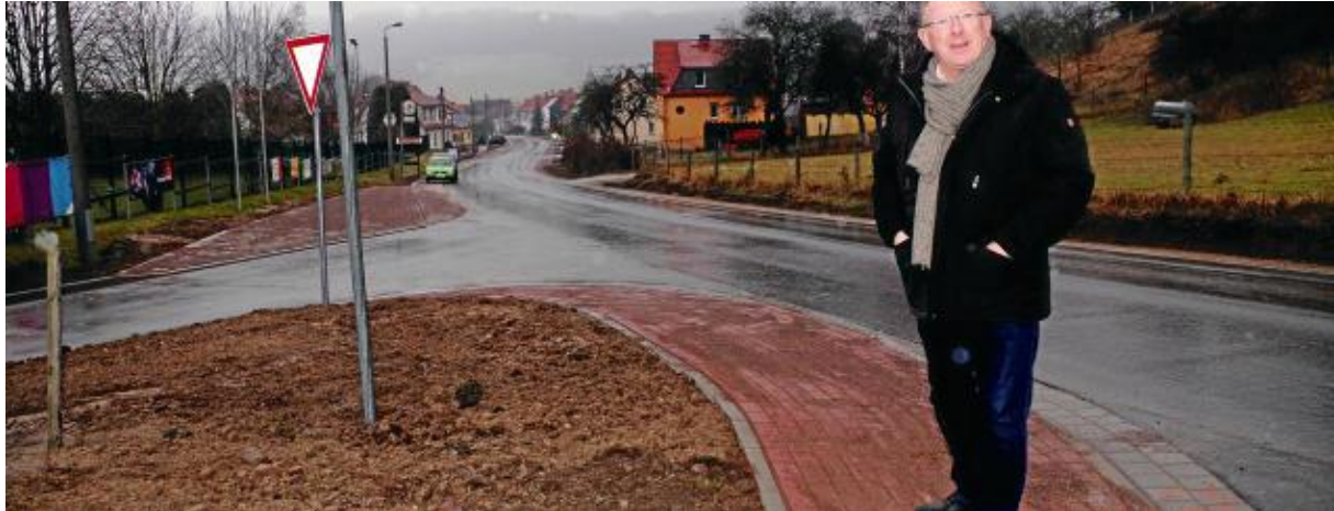
Der Neuausbau der Landesstraße L 2032 in der Ortsdurchfahrt Großbartloff zwischen Lutterbrücke und Ortsausgang Richtung Wachstedt ist weitgehend abgeschlossen. Bürgermeister Winfried König, hier an der neu gestalteten Verkehrsinsel am Ortsausgang, ist sehr zufrieden. Foto: Jürgen Backhaus
