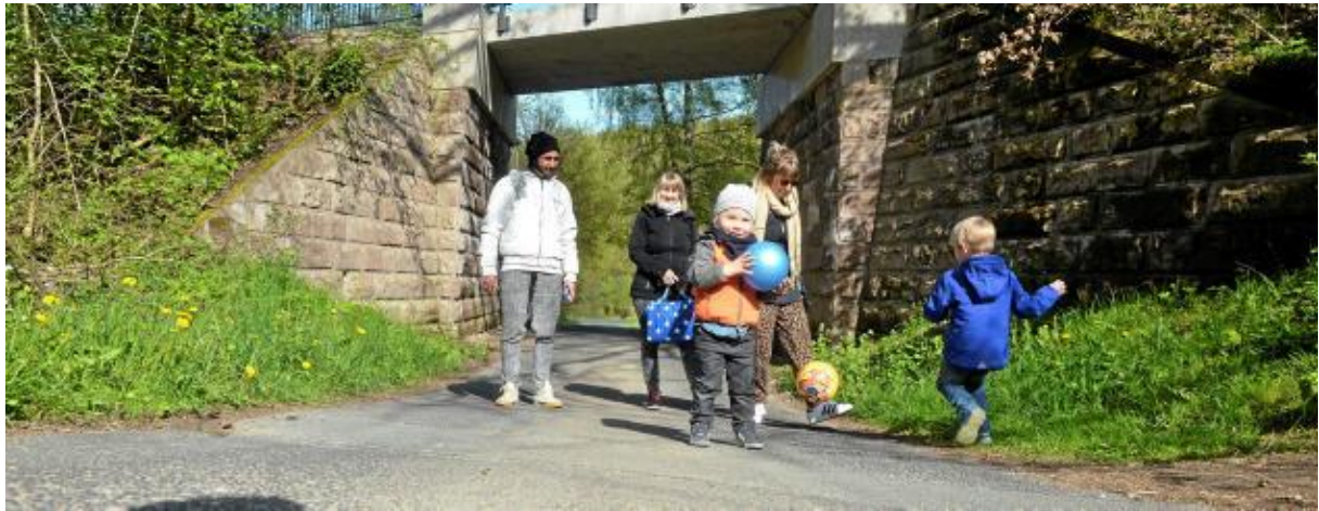
Eine der für den Radweg "Südeichsfeldroute" erneuerten Brücken bei Neunbrunnen. Foto: E. Jünger
